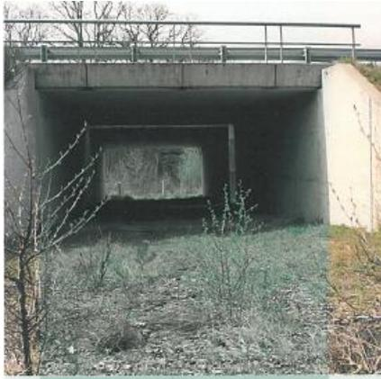
A: Passage à faune inférieur sur l'A71 (largeur 6 m, hauteur 3m)
