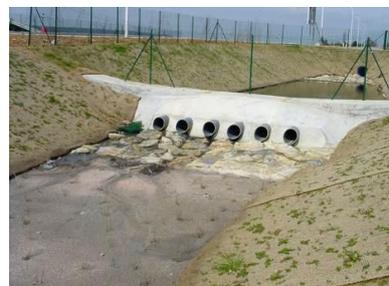
B : gauche : exemple de bassins à filtres de roseaux plantés, centre : décanteur à sortie siphonide, droite : sortie du décanteur vers le bassin planté avant végétalisation (source : Sinbio)
